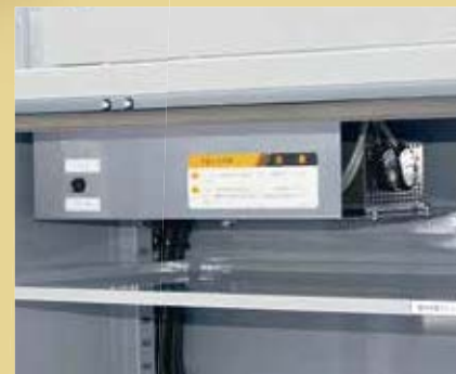
》 インバーター OP 最大出力: 1kW 定格出力: 800W 出力電圧: AC100V
